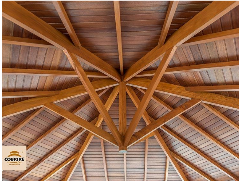
Figura 2 - Detalhe da sustentação central da cobertura dos caramanchões Fonte: https://cobrire.com.br/quiosque-cobertura-de-telha-portfolio/
